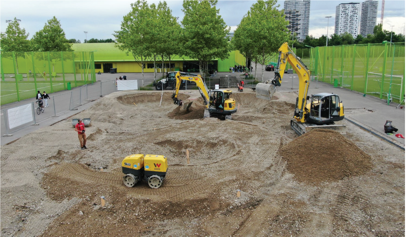
Baustelle Pumptrack Hirzenbach auf der Sportanlage Heerenschürli.
